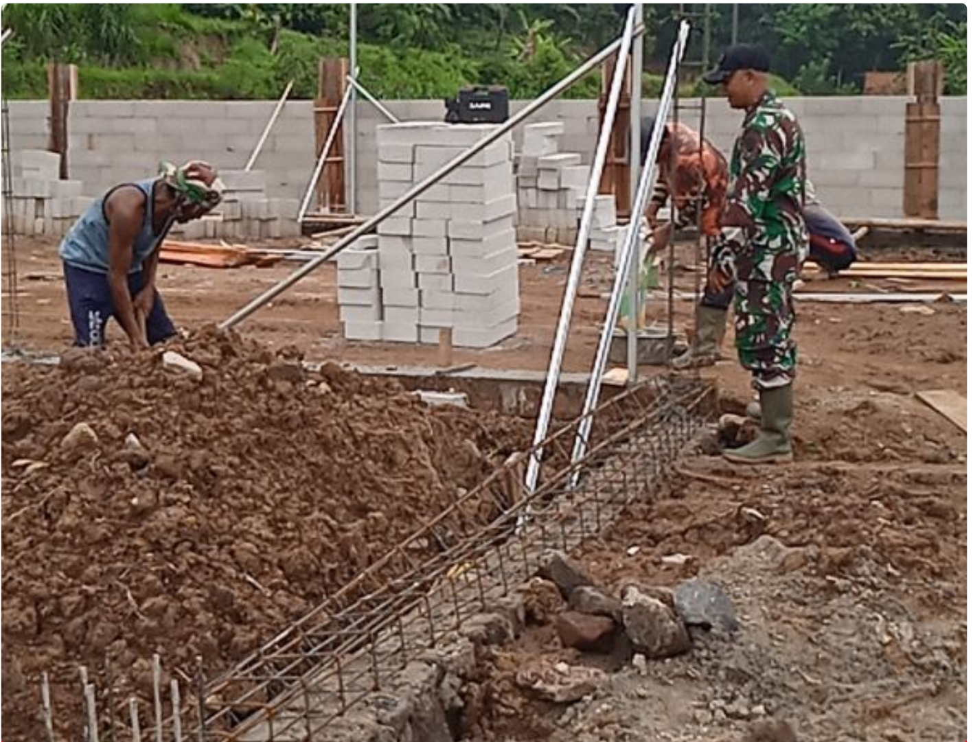
Pembangunan KDKMP Desa Cipicung
